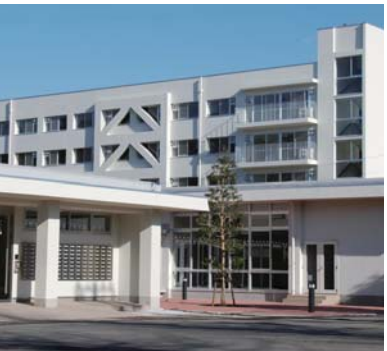
学生寮（水戸地区） Student Dormitory (Mito Campus)
